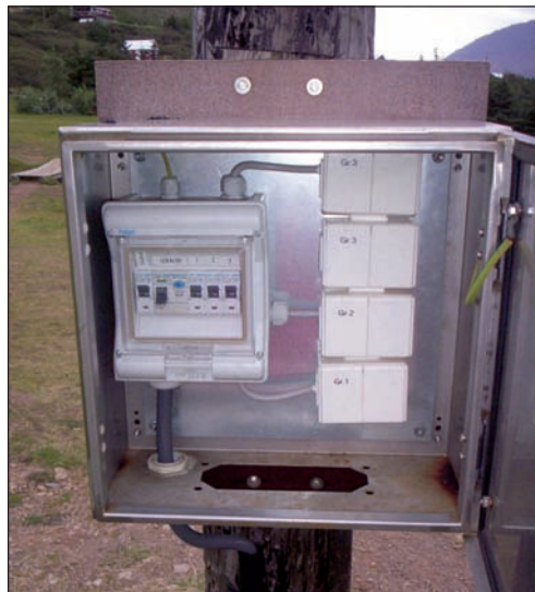
Mynd 7. Ekki er heimilt að tengja hjólhýsi og húsbíla við þessa gerð tengla.
