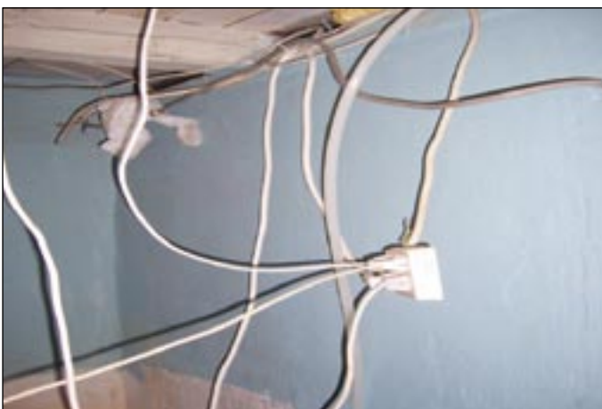
Mynd 6. Rangur frágangur raflagna og rafbúnaðar.
